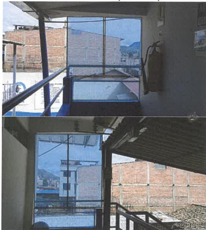
El contratista realizara el suministro e instalación de Suministro e instalación de 5.30 m<sup>2</sup> de muro de vidrio templado de 4 mm reforzado con tubos cuadrados metálicos de 2 plg x 2 plg e= 2 mm; en todo el perímetro y sellado Adhesiva Elástico De Alto Agarre Construc Sikaflex o producto similar
