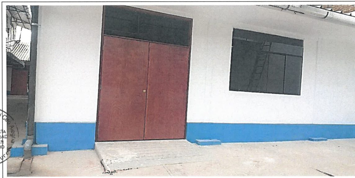
Rampa de acceso para salón de ajedrez - Local Ramiro Prialé
