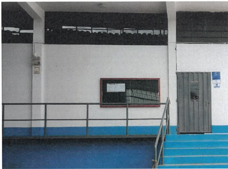
Barandas de seguridad - Local Ramiro Prialé
