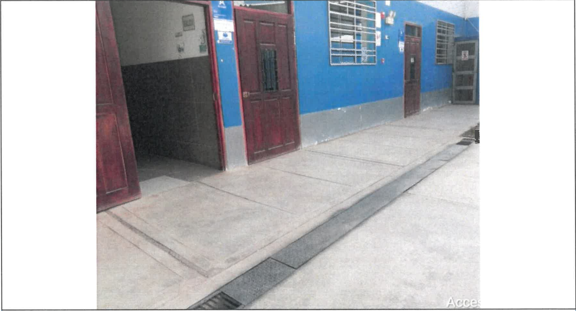
Rampa de acceso para Los ambientes del Pabellón A- Local Garcilaso
